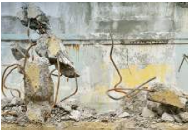
Béton de démolition
